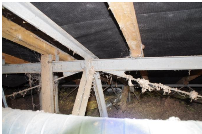
Assemblage panne T2 sur ferme treillis
