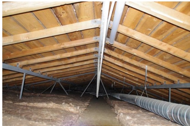
Ferme treillis et pannes sous-tendues T1
