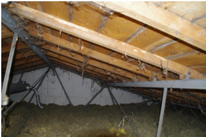
Ferme treillis et pannes sous-tendues T1
