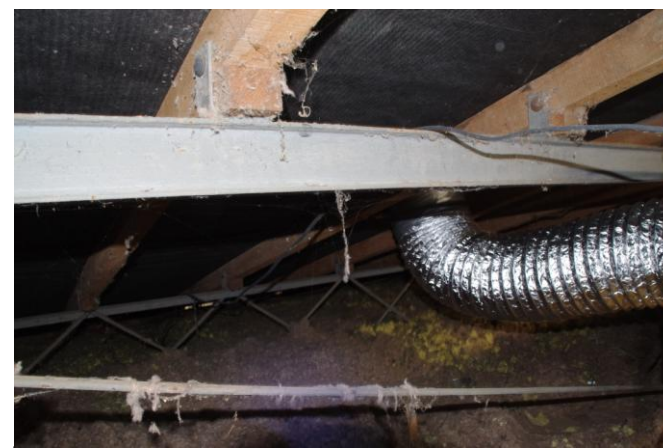
Détail assemblages chevrons sur pannes T2
