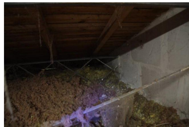
Recoupement de combles en carreaux de plâtre
